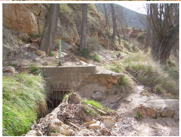
FOTO 16. Azud Rambla de Libros, de 2m de altura de hormigón para riego. Canal de derivación
