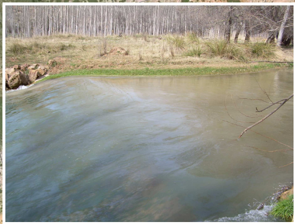
FOTO 16. Azud Rambla de Libros, de 2m de altura de hormigón para riego. Canal de derivación
